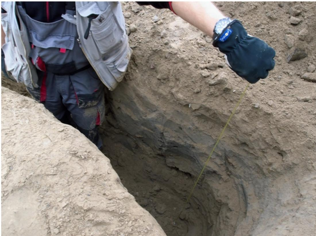
После разметки трассы отрыть траншею глубиной не менее 0,7 метра по выполненной разметке и подготовить приямки в местах заглубления вертикальных электродов. Ширина траншеи должна быть достаточной для проведения работ.
