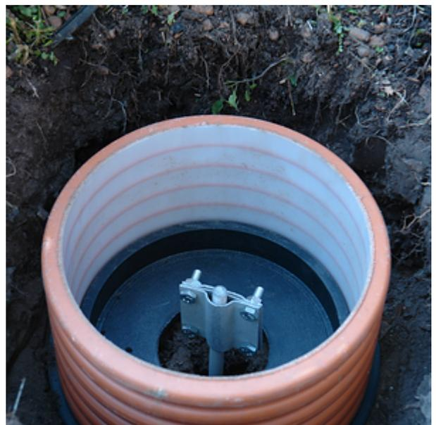
может предусматриваться установка смотрового колодца для обеспечения возможности периодического визуального контроля и доступа к соединению.
