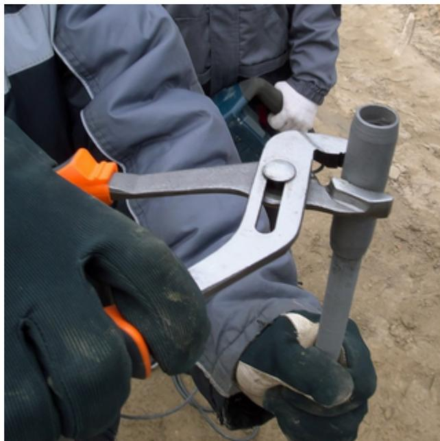
Рекомендуется очистить резьбы стержня, втулки, удароприемной головки от возможного мусора. Предварительно «прогнать» резьбу.
